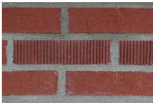
Bild 3.2d. Närbild, från samma mur som bild 3.1, inmurning av räfflat tegel med mörkare kulör, i mur med borstad yta.
