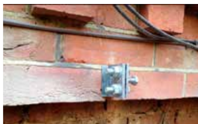
Bild 4.2. Anordning för att öka tryckkraften i horisontal led på skiftet ovan öppningen/fog. (Brick Brace Ltd)
