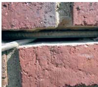
Bild 4.17. Bilden visar det yttre armeringsjärnet som är utbytt till ett rostfritt.
