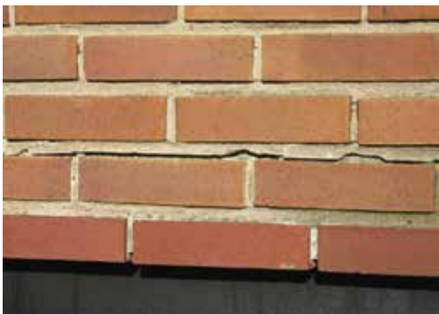
Bild 1.1. Tydlig horisontal spricka på grund av rostsprängning i murverk över fönster, studentbostadsområdet Vildanden i Lund, byggt 1966.
