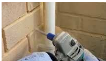
Bild 4.5a. Vinkelslip försedd med fogfräs. Finns med eller utan styrning, i detta fall utan.
