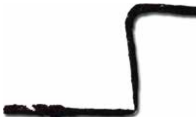
Bild 1.18. Frilagd rostangripen Z-formad kramla, uttagen vid en fasadrenovering av ett bostadshus på Kobjer i Lund, byggår 1954.
