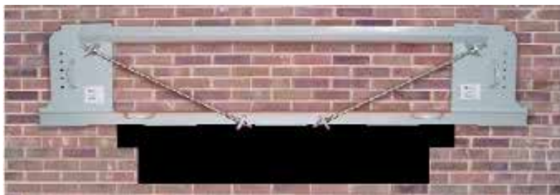
Bild 4.14. Ett hjälpmedel för att undvika ras vid håltagning eller då det första skiftet/skiftena tas bort och ersätts (Diversity Products Ltd, No More Props).
