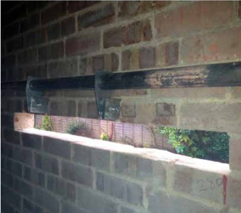
Bild 4.3. För att öka kapaciteten i vertikalled kombineras anordningen i bild 4.2, med i detta fall en stålbalk med cirkulärt tvärsnitt. (Brick Brace Ltd)
