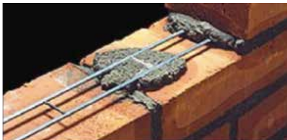
Bild 1.19. Bistålsarmering (foto Murma).
