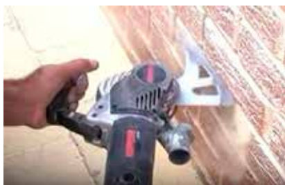
Bild 4.7a. Specialmaskin anpassad för borttagning av fog. (Arbortech Tools, AS170)
