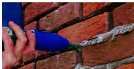
Bild 4.11a. Fogspruta, driven av bormaskin.
