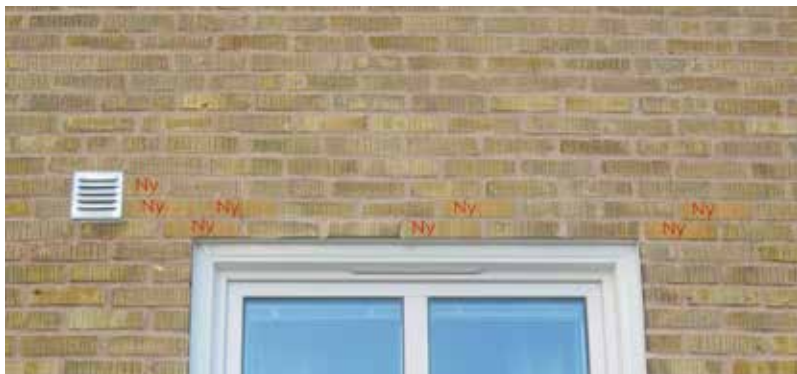
Bild 2.2. Reparation av murverk över fönster, utfört genom ommurning och med utnyttjande av valvverkan. Befintliga och nya tegel blandades vid återmurningen. Foto: Frej Josefsson, Morneon Fasad AB.
