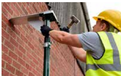
Bild 4.1. Provisorisk stötta för att avlasta murverket ovan öppning/fog. (Heaton Products Ltd)
