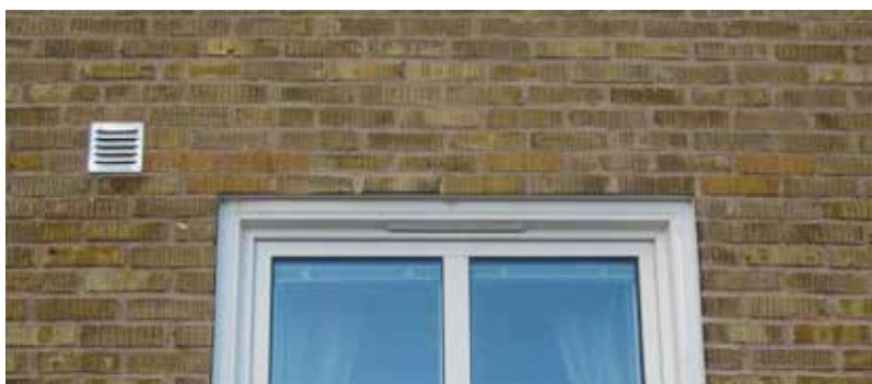
Bild 2.3. Samma fönsterbalk som i bild 2.2, utan markering i tegelstenar. Foto: Frej Josefsson, Morneon Fasad AB.
