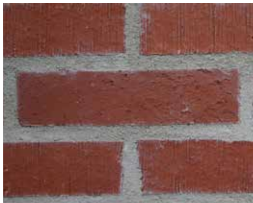
Bild 3.2b. Närbild, från samma mur som bild 3.1, inmurning av spånat tegel (andra skiftet nedifrån) med något mörkare kulör, i mur med borstad yta.
