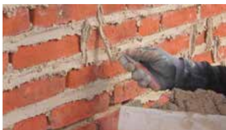
Bild 4.9a. Traditionell fogning/omfogning med fogplatta och fogslev
