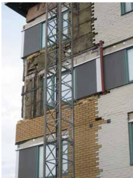
Bild 2.1. Fasadrenoveringsarbete, studentbostadsområdet Parentesen, Lund, innan målning av fasaden.
