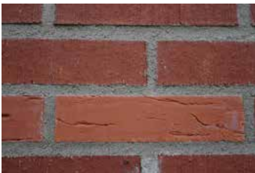
Bild 3.2c. Närbild, från samma mur som bild 3.1, inmurning av tegel med valsad ytstruktur och ljusare kulör i mur med borstad yta.
