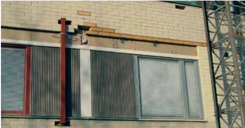
Bild 4.15. Stämpning av 5.4 m lång muröppning, Parentesen, Lund. Fasaderna målas i efterhand. Murverket ovan öppningarna ges efter renoveringen upplag i sin mittpunkt av stålkonsole, som fästs in i bjälklagskanten. Stämpan tar ned lasten från ovanliggande murverk när första skift över fönstren och ovanliggande armering avlägsnas. Murverket är armerat i första fog över och under fönsteröppningarna. All längsgående armering, även i murpelare mellan öppningarna, tas bort.
