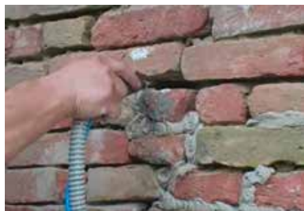
Bild 4.12a. Fogspruta, driven av extern pump.
