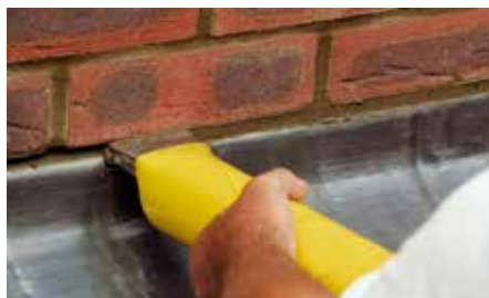
Bild 4.10a. Fogspruta, pumpas med handkraft.
